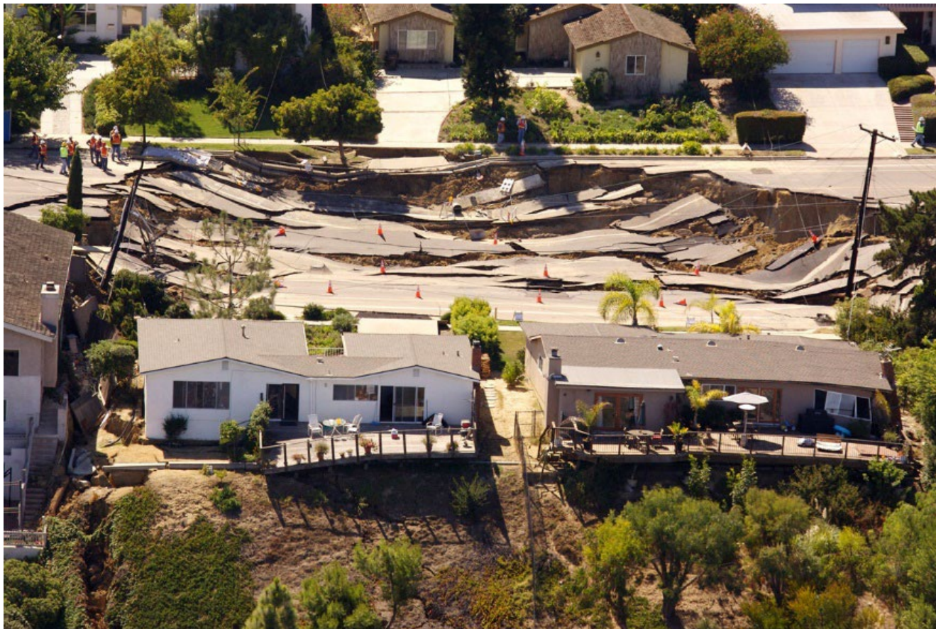
Mt. Soledad Landslide, San Diego, CA
