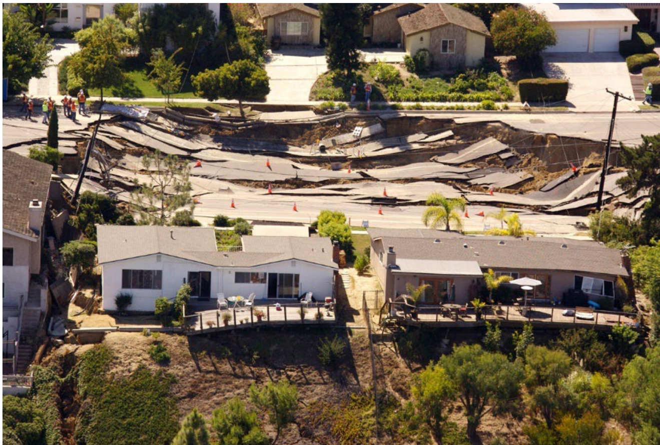
Mt. Soledad Landslide, San Diego, CA
